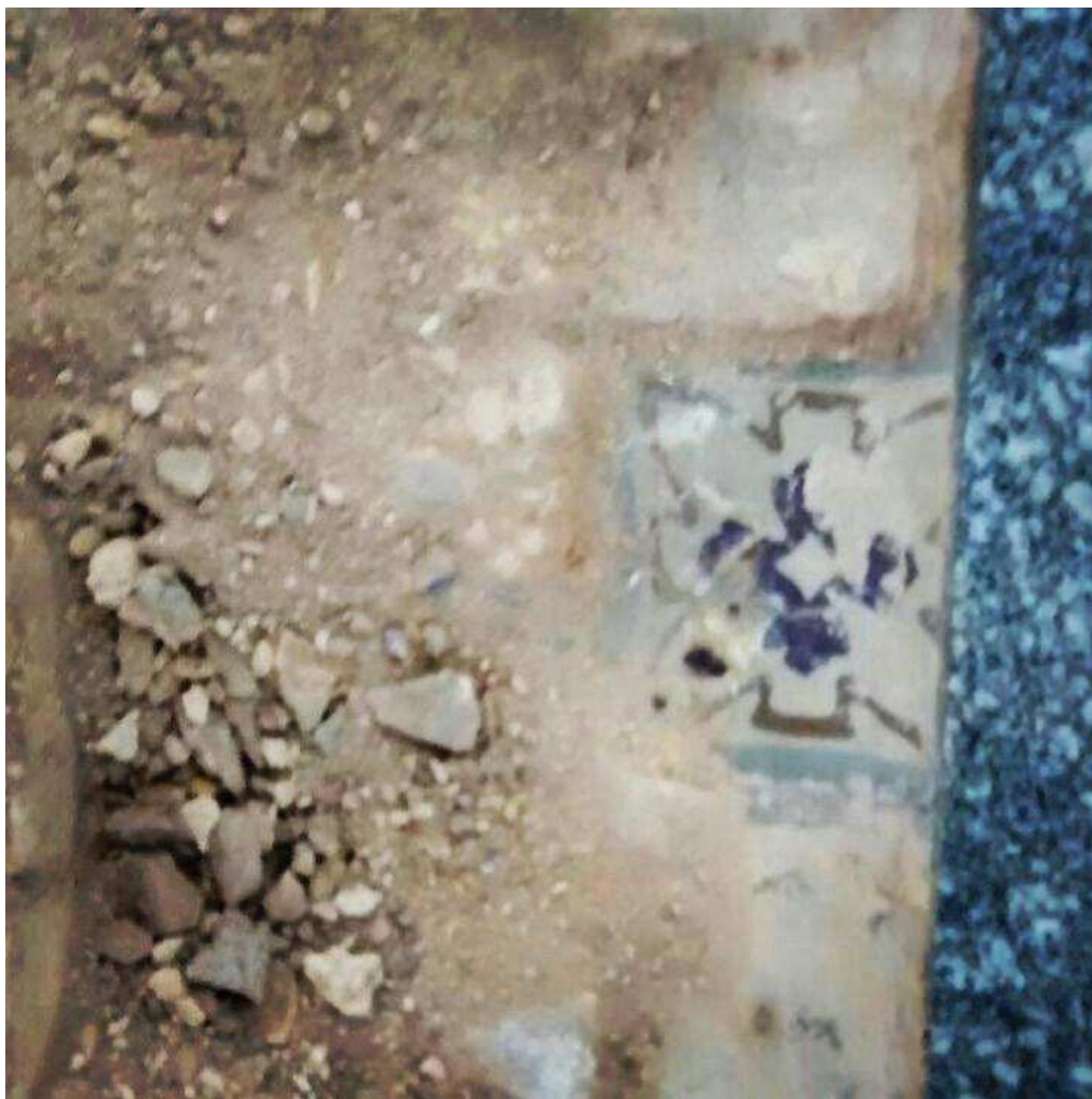
Ladrilhos originais da Matriz soterrados sob o acréscimo do presbitério de 1971
